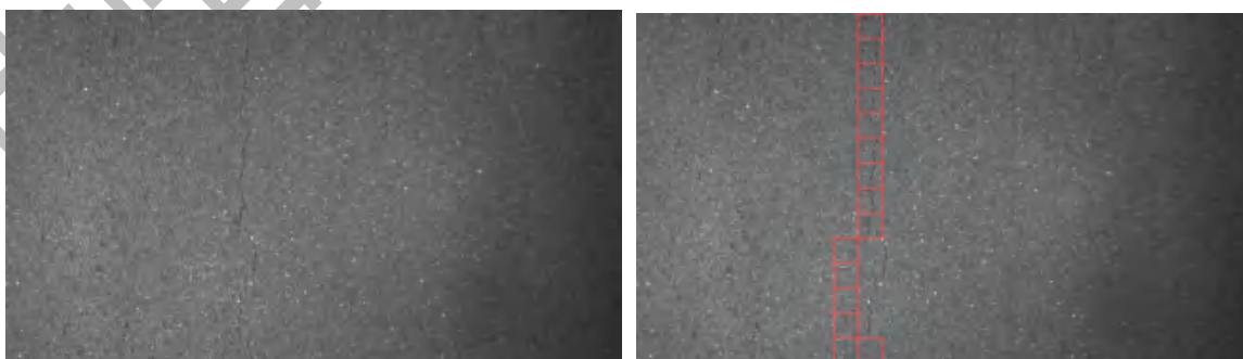
图 7 纵向裂缝场景图
